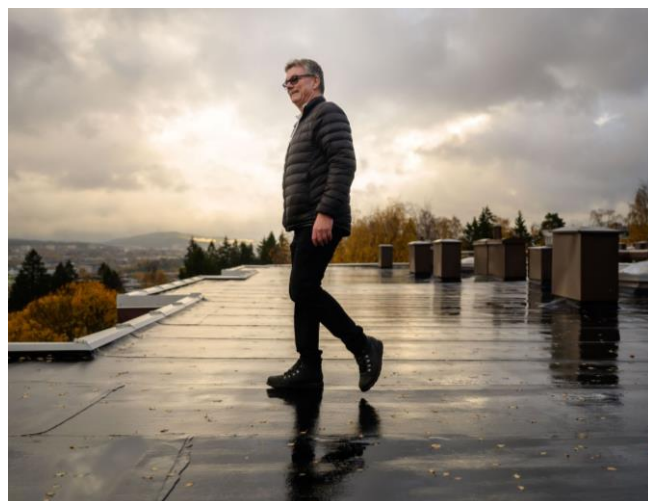
På dette taket håper Holmen å få solcelleanlegg til våren. – Det vil kunne produsere mellom 70 og 100 kWp, forteller han.
