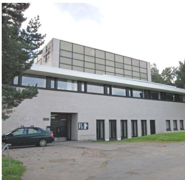
Inngangen til møterommet er gjennom døren nederst til venstre på bildet.
