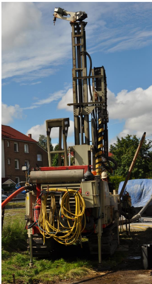
Slike borerigger dukker snart opp på Lohøgda også. De er langt fra lydløse, men boringen går ganske raskt unna.
